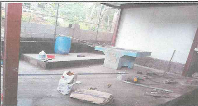
Foto 3: Sustución de patio de tierra por torta de cemento.
