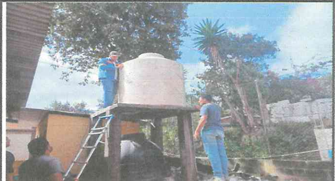
Foto 2: Colocación de tinaco de tres capas de 1700 litros.
