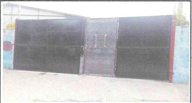
Foto 4: Colocación de lámina negra e instalación de chapa yale y aplicación de pintura corrosiva.
