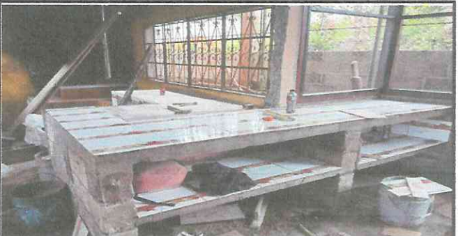
Foto 6: Elaboración de gabinete de cemento.
