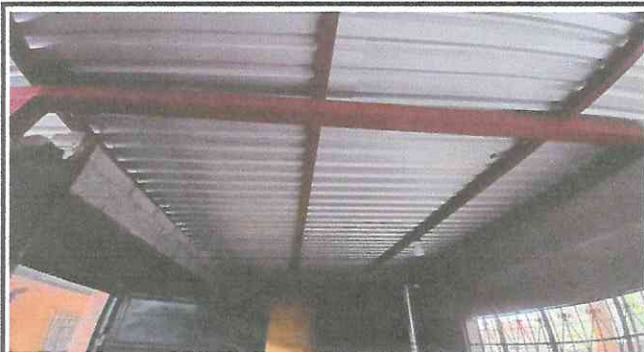
Foto1: Colocación de infraestructura metálica con lámina troquelada alucin.
