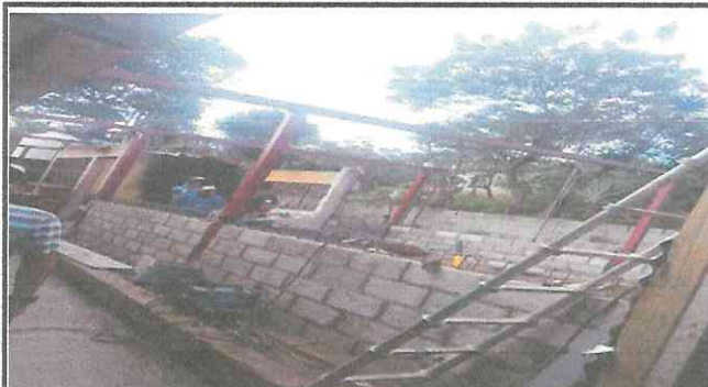
Foto 2: Sustitución de pared de cocina de lámina por block.
