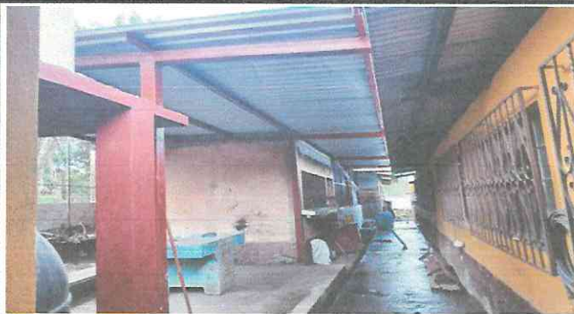
Foto 3: Colocación de infraestructura de metal y lámina troquelada aluzic calibre 26.
