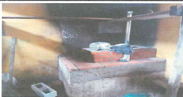
Foto 5: Elaboración de polletón con chimenea y plancha de metal.
