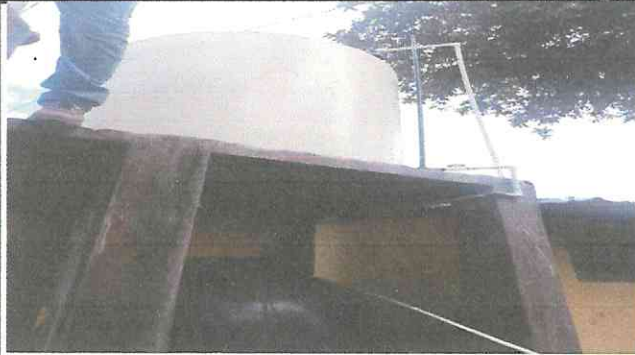
Foto 1: Instalación de tubería, llaves y contra llaves y reforzamiento de terraza.
